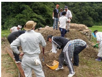
図6 窯の屋根に土を被せます。とても重労働で、へとへとになりました。
