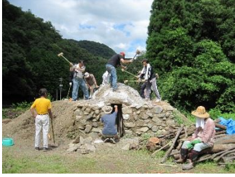
図7 皆で、槌を使って屋根を突き固めました。
